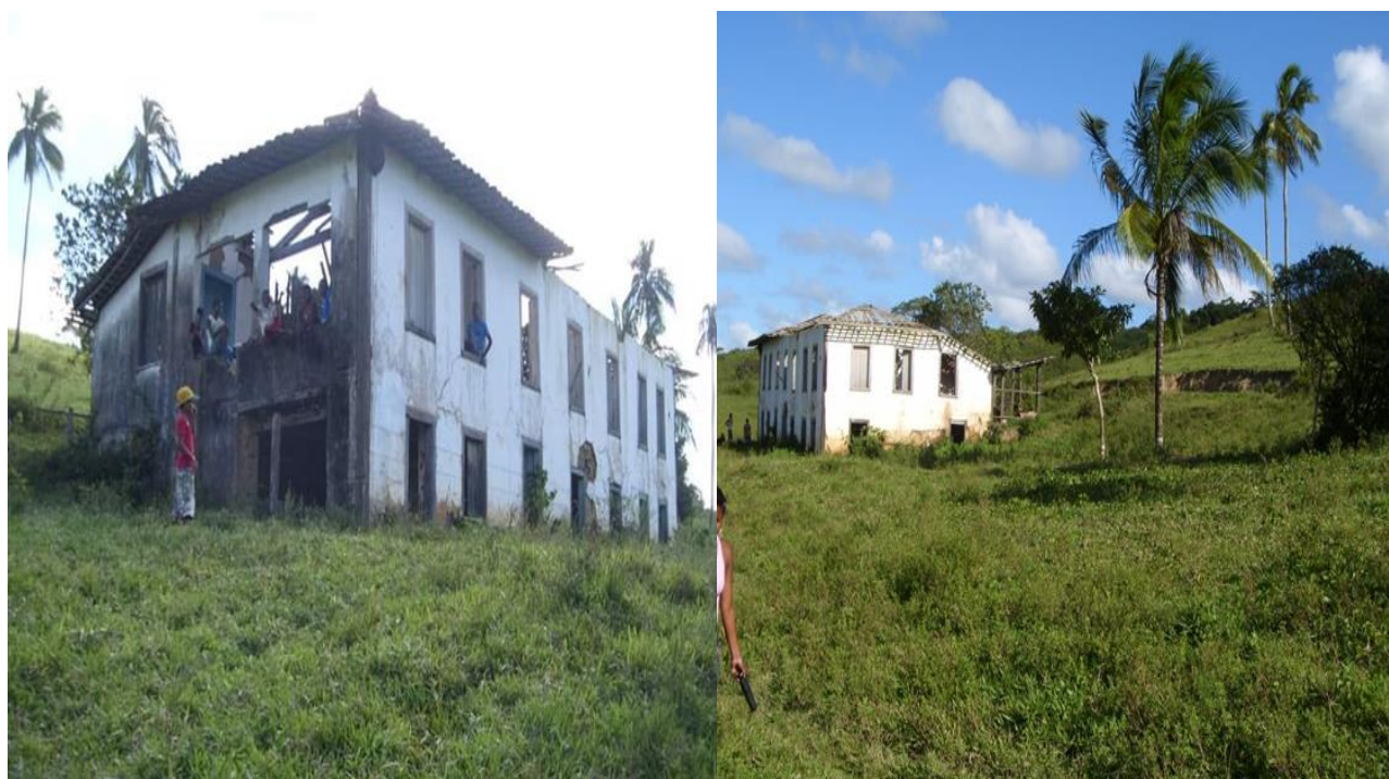
Ruínas da Fazenda Cambuí na comunidade do Jangada- Cardeal da Silva. 2010
